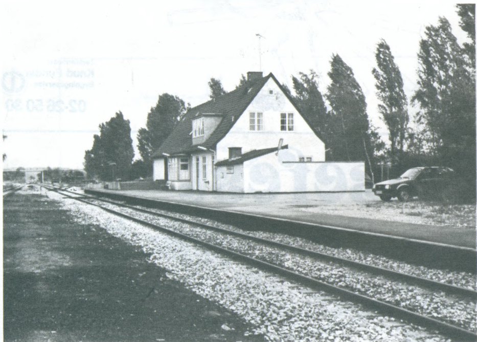
Brødskov Station. Nednormeret til trinbræt.
