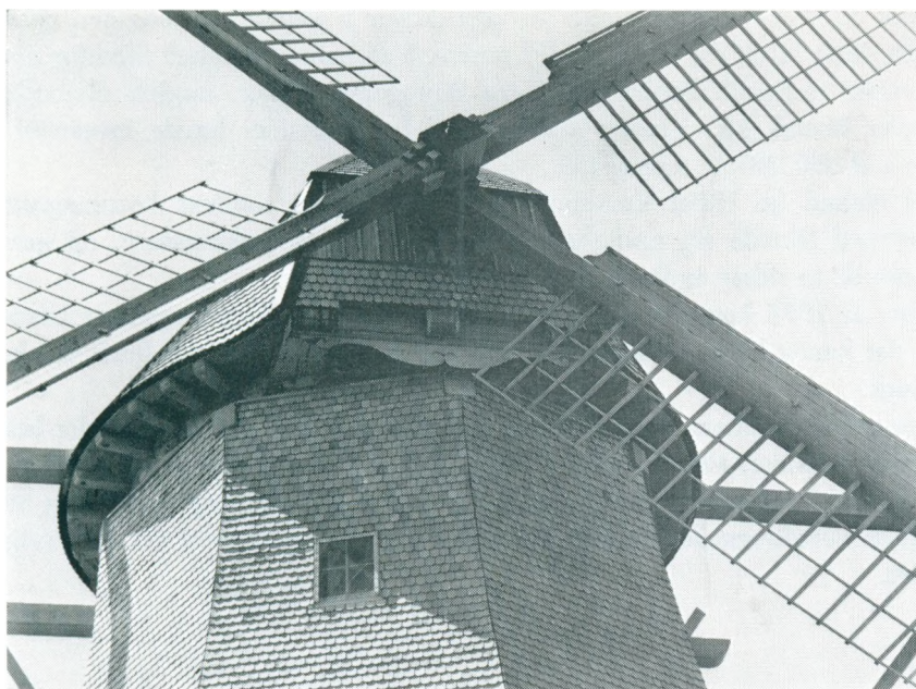
Fig. 12. Møllens ansigtsspejl som kunne bære fire årstal: 1569 – 1739 – 1857 – 1977, som markering af møllens hoveddata. Hatten vejer 17–18 t.
