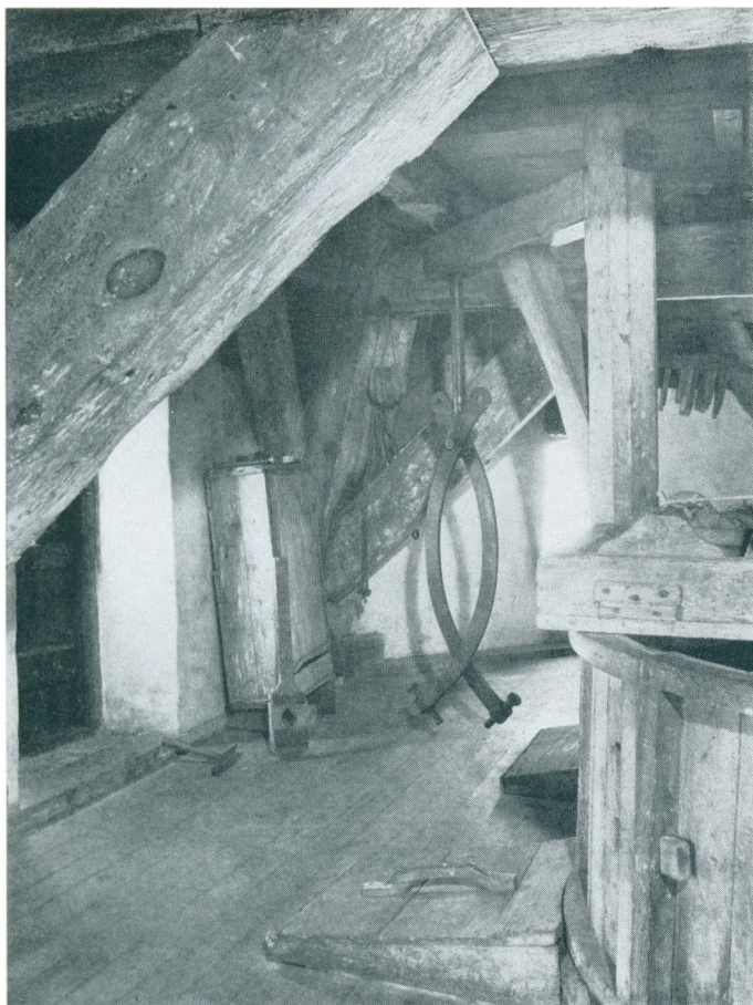
Fig. 8. En af møllens fire kværne («franskeren»). Kranen med gribe-arme benyttes, når møllestenene loftes fra hinanden for at blive skærpet. På gulvet en pighammer, der bruges ved skærpingen.
