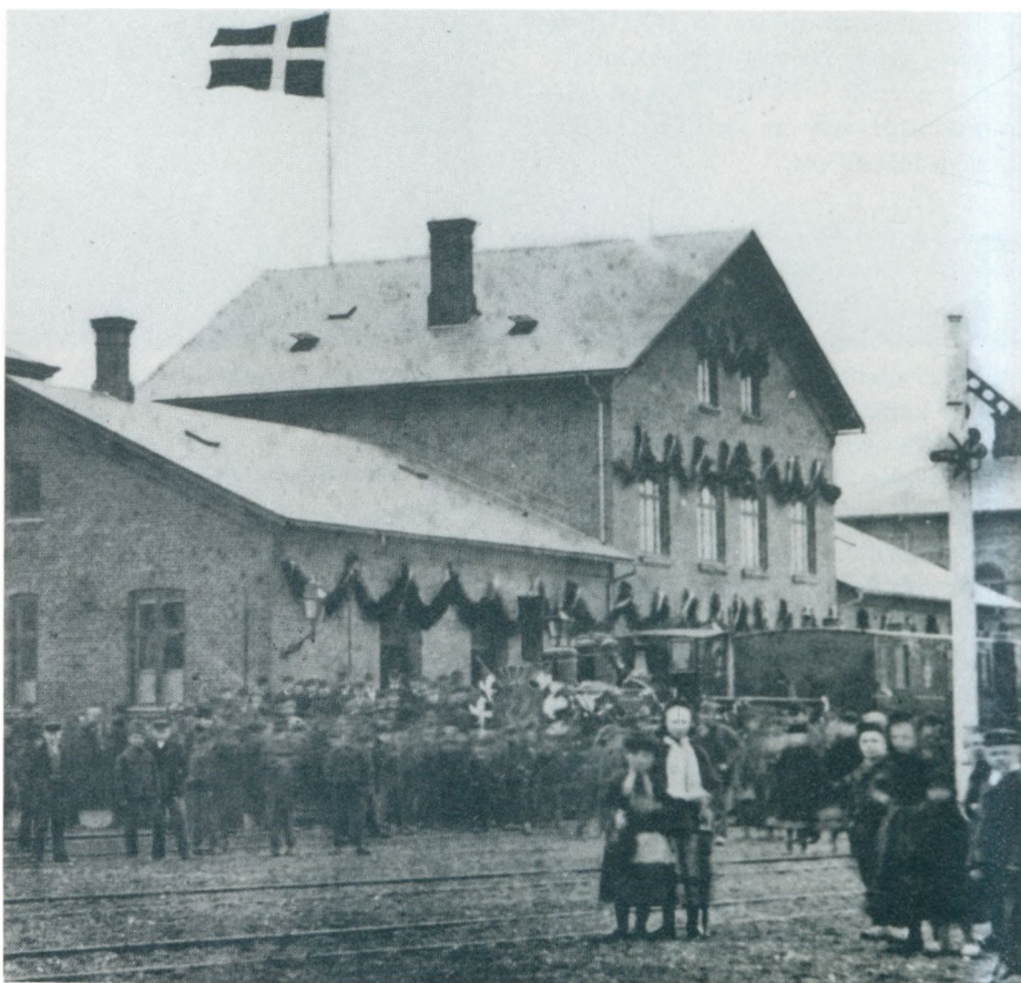
Den nye stationsbygning i Faaborg. Fra indvielsen af Ringe–Faaborg Banen den 1.4.1882
