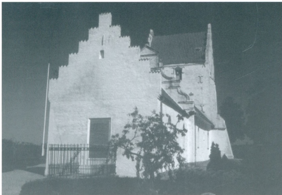
Refsvindinge kirkes østgavl med Fr. Baggers mindetavle
