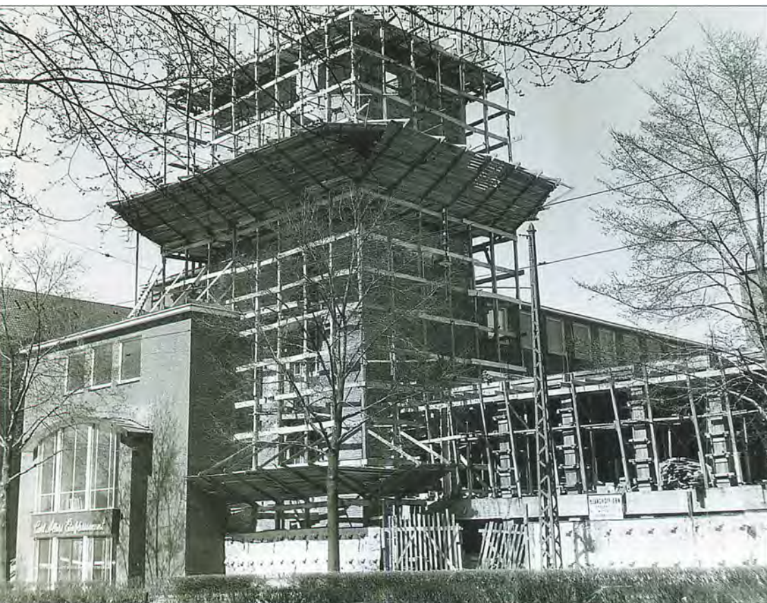
Fløjen langs Kjeldsgaardsvej i Valby er rejst, og i 1947 er hovedtårnet og første del af Vigerslev Allé-fløjen også på vej
