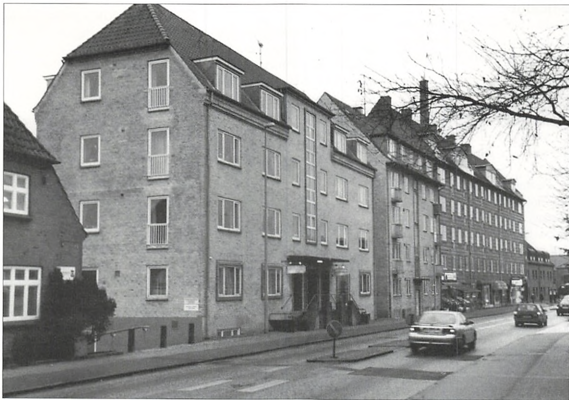
Facaden af ejendommene Hostrupsvej 21-29 i "vore dage" (Fot. Flemming Beyer 1998)
