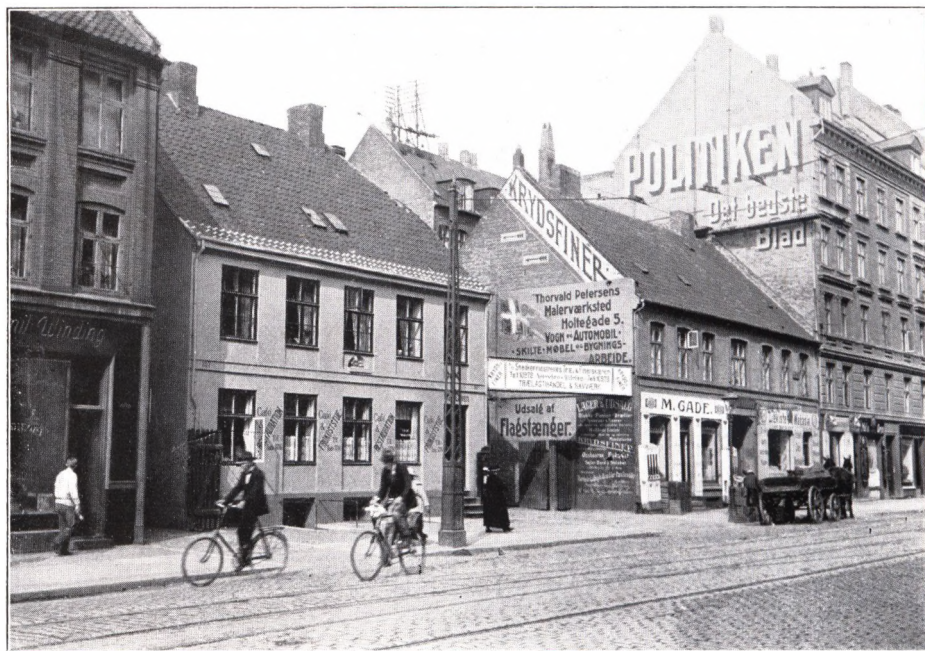
Skæreriet paa Nørrebrogade. Façade mod Gaden
