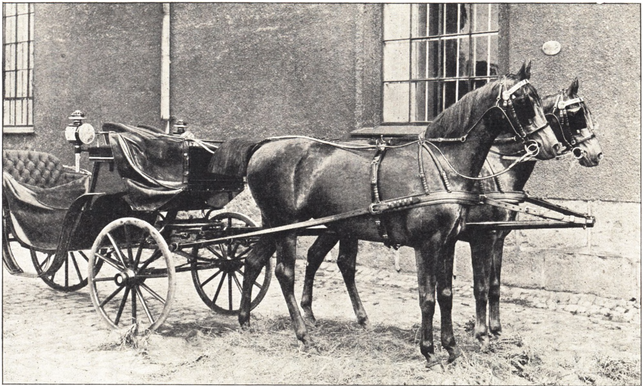
Et smukt Forspand fra Hestekøretøjernes dominerende Tid med fikst og veludført Seletøj og fin polstret Vogn.
