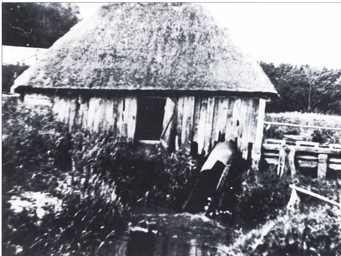
"Æ snegl". Arkimedesskruen, som pumpede Munkesø tør. Huset lå, hvor Skallebækken flyder ud af søen. (Foto fra cirka 1910.)
