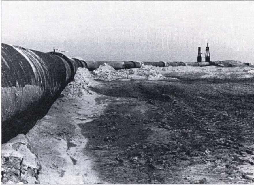
Sandpumperens forbindelsesrør til land.
