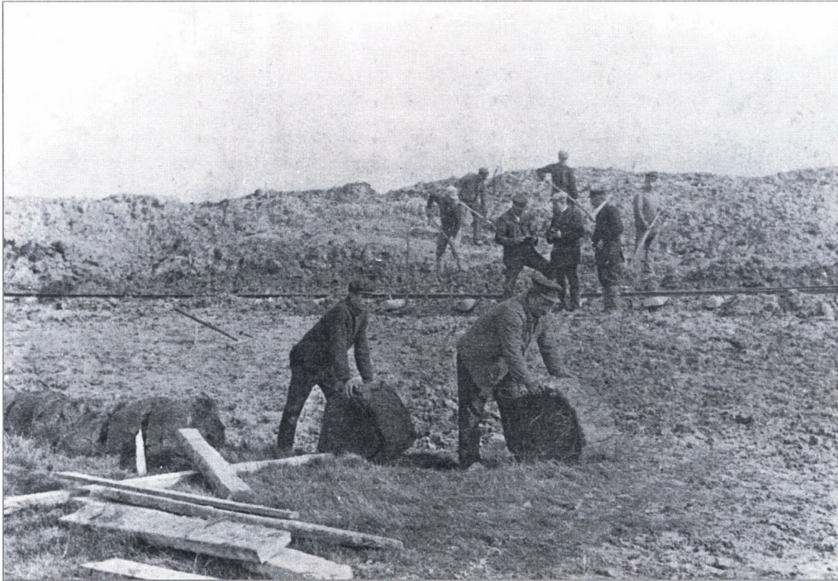
Græstørvene rulles op og lægges til side, indtil de skal pålægges digeskråningen. Foto i Sydvestjyske Muséer
