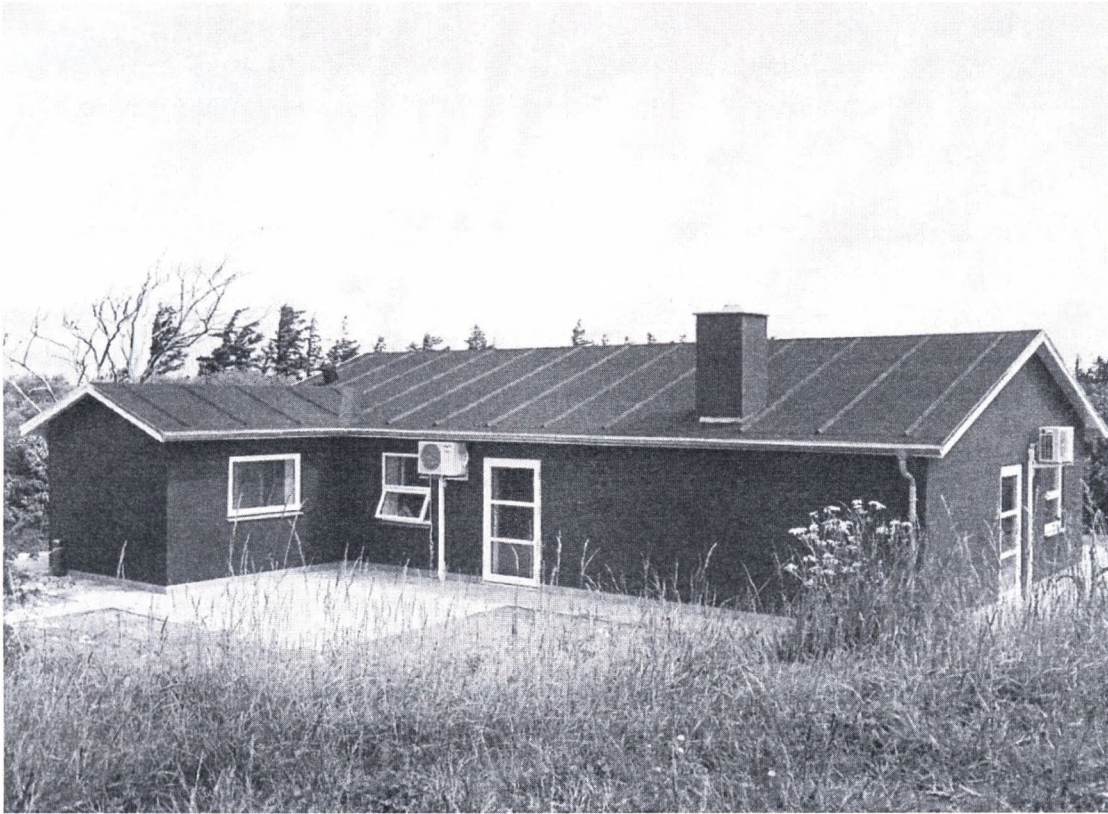
Digehytten i Vester Vedsted. Den rummer resterne af en mandskabsbarak fra Digebyggeriets tid. Længe var den i privateje. Nu ejes den af Esbjerg Kommune. Foto i Lokalthistorisk Arkiv i Vester Vedsted
