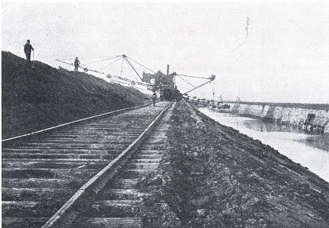
Gravemaskine med indstillelig transportør. Dige og Fyldgrav. Foto: Ingeniør Kr. Thomsen
