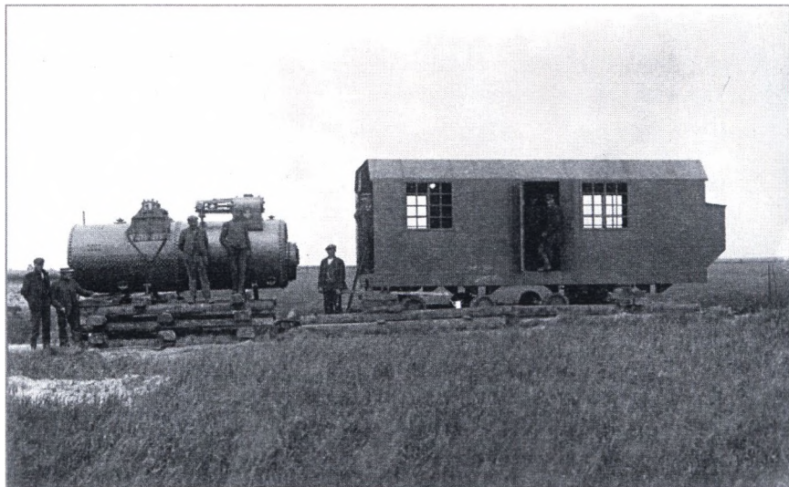
Dampkedel, hvor dampmaskinen sidder på oversiden, huset er til spandekædegravemaskinen. Foto formodentlig fra opsætning af maskinen. Foto i Sydvestjyske Muséer
