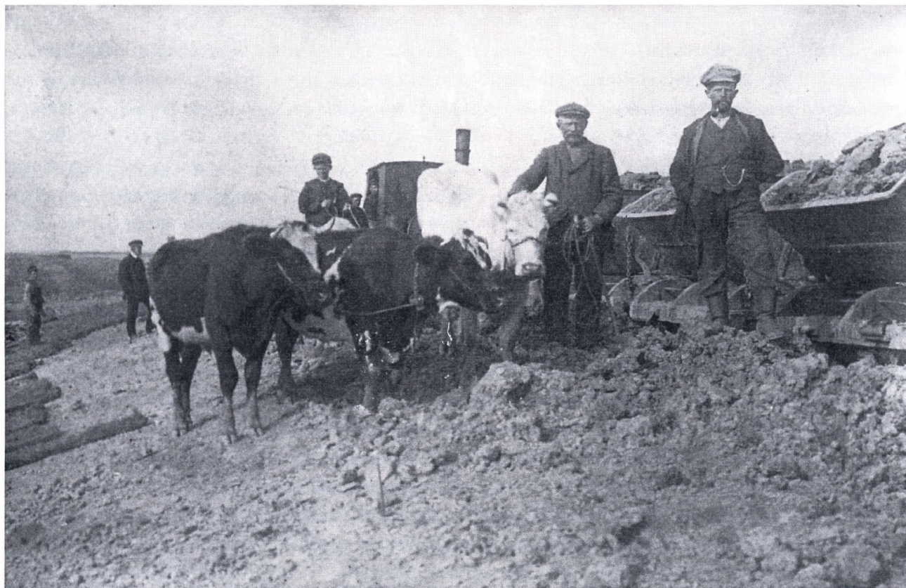
Stude, som tramper jorden fast. Foto tilhører Torben Hestehave
