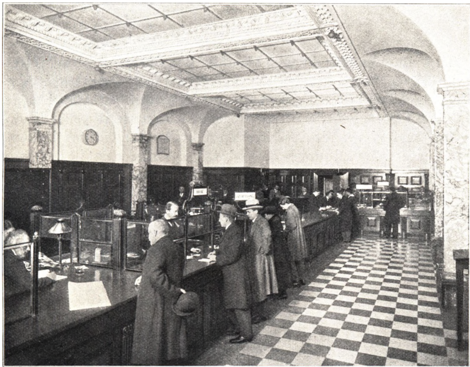
Hovedkontoret efter Ombygningen. (Den overbyggede Gaard.) Indbetalingen
