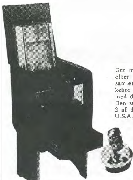
Fremkalderudstyr til DAGUERREOTYPI-plader (Kviksølvboks) fra ca. 1845.
