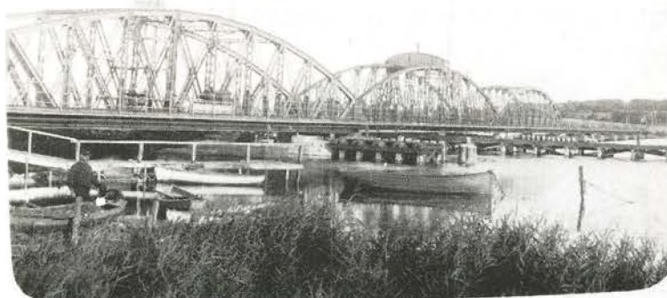
Hadsundbroen 1934. Udskiftning af svingpartiet. Foto: M.P.
