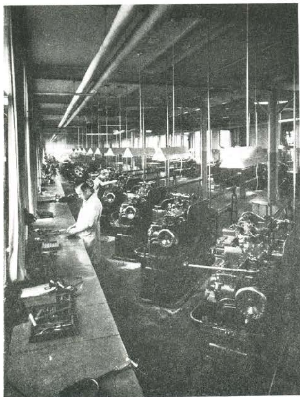
Automatdrejeafdeling hvor små drejemner fremstilles fra stangmateriale.
