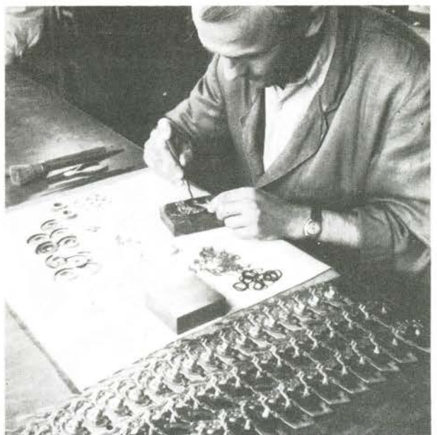
Undermontage af Rolleiflex-optræksarm.
