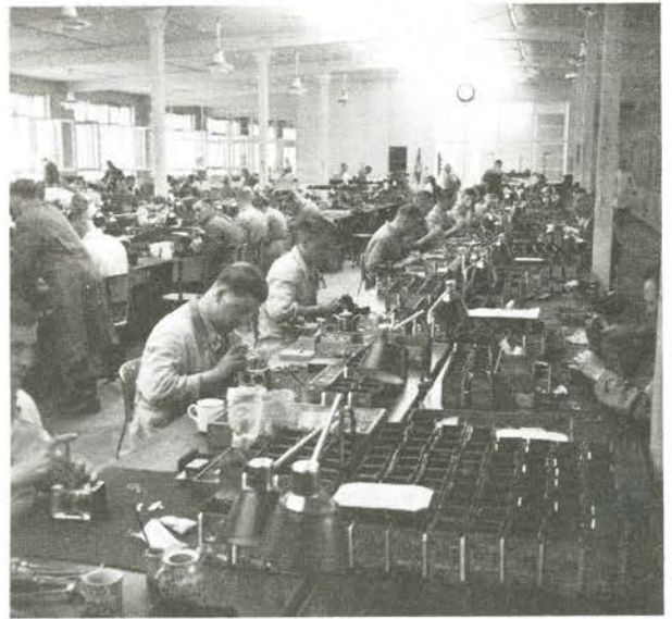
Finmekanisk montage af kamerahuse.
