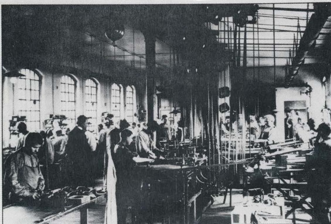
I 1910 var produktionsforholdene præget af hånd- og dampkraft, hvor de enkelte kameraelementer måtte gennemgå utallige arbejdsprocesser. Begge billeder er fra 1910.
