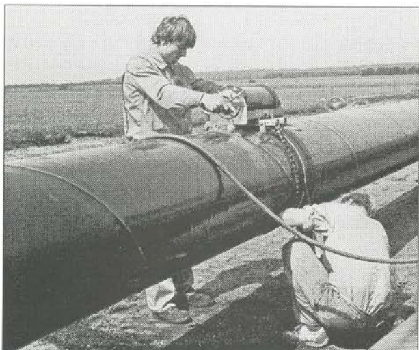
Indførslen af naturgas medførte et stort salg af røntgenfilm til undersøgelse af svejsesømme – her placeres en 2 meter x 20 cm røntgenfilm rundt om gasledningen.
