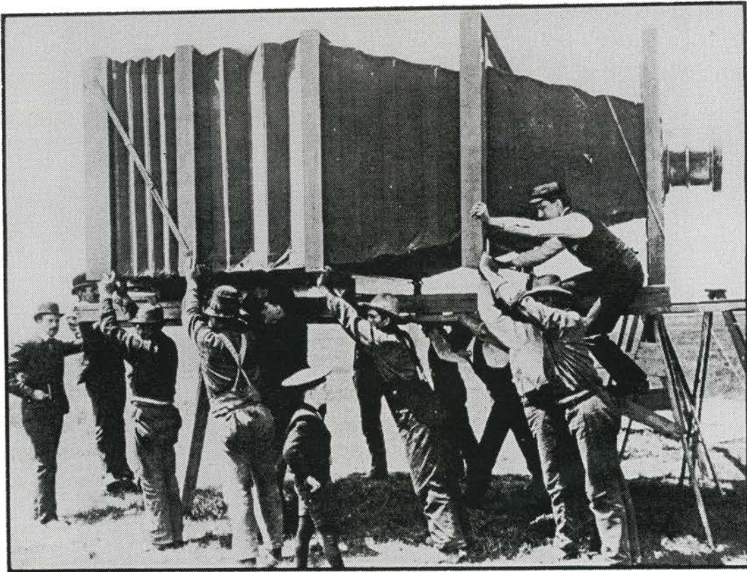
Det enorme kamera er ved at blive kørt i stilling til den første prøveoptagelse. Bælgen var indvendig beklædt med sort gummilærred og sort kanvas for at gøre den 100 % lystæt.
