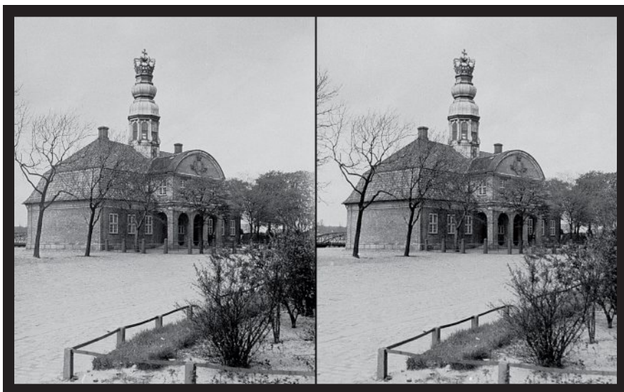
Administrationsbygningen på Orlogsværftet
