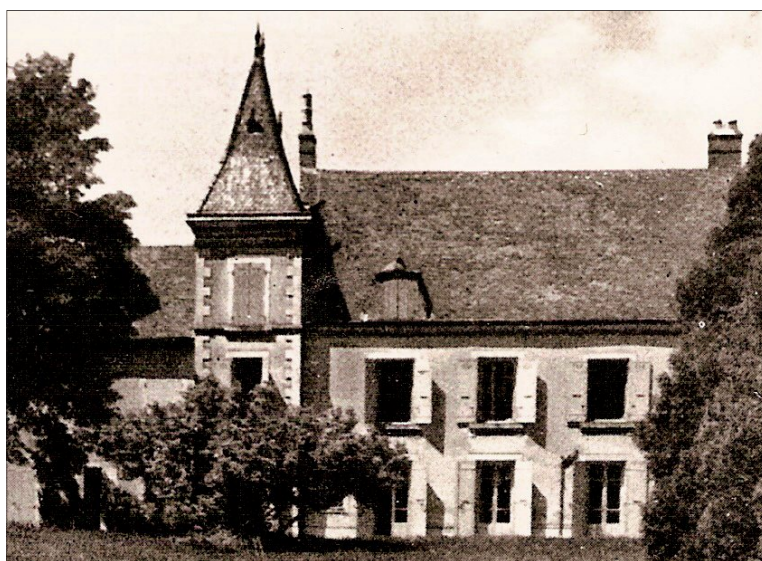
La Maison du Gras i Saint-Loup-de-Varenne
