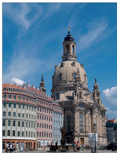
Den genopbyggede Frauenkirche
