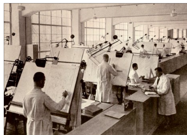
Det første skridt. Konstruktorerne i arbejde
