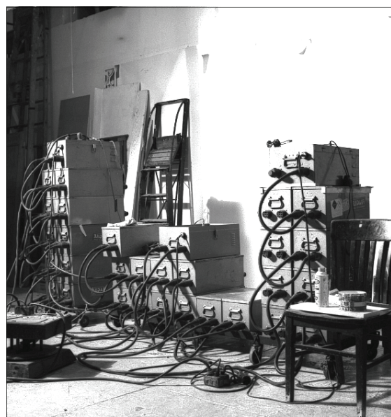
Med en lysfølsomhed på kun 12 ASA var enorme lysmængder nødvendige, når de store 8 X 10" film skulle eksponeres. Ascor anlægget (435000 Joule) var udviklet til US Aierforce. Vi fotograferede engang Empire State Building fra top til fod med elektronflash. Det lykkedes
