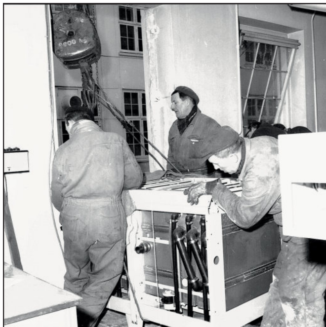
De dygtige transportfolk har fået fremkaldemaskinen ind gennem muråbningen. Det ses tydeligt, at fremkaldemaskinen består af et gråmalet stel af rustfrit stål. I stellet står de modulopbyggede tanke. Alle Pako tanke er udført i austenitisk syrefast stål, som kan modstå angreb fra blegebade og blegfixerbade.
