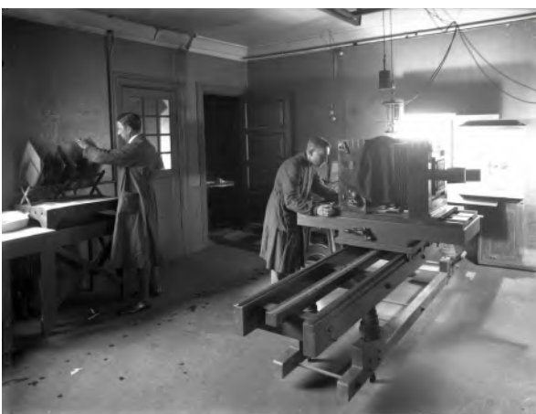
Kamera med vendeprisme foran optikken for at få det til at stå retvendt på glaspladerne, som ses ovre til venstre.
