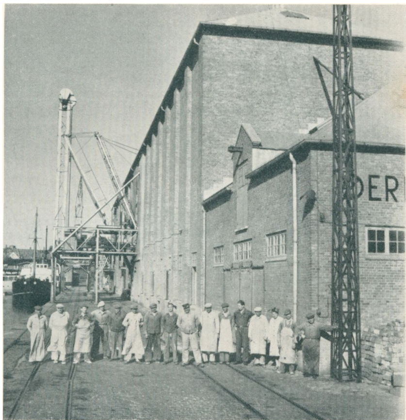
Pakhusarbejderne i Rønne.
