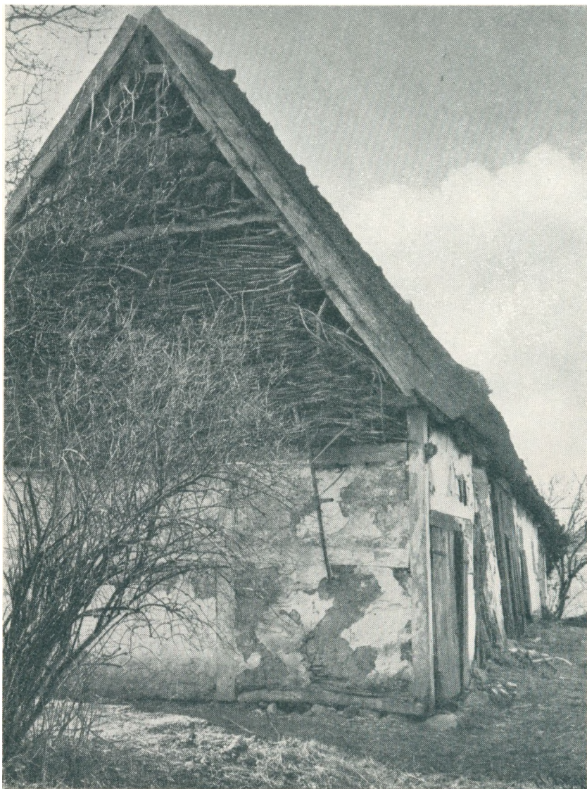
Risflettet Gavl, der foroven har været suppleret med Halmdukker. Bønsvig, Jungshoved Sogn. Man ser det sydsjællandske solide Bindingsværk med gennemtappede Bjælker og indtappede Løsholter ved Hjørnestolpen. (B 136).
