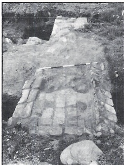
Fig. 3. Rester af bropille fra 1500-årene. De yderste teglsten står skråt, da de er den nedre del af det murede hvælv, der har været mellem bropillerne. Bagerst i billedet det kvaderstenshugne kampestensfundament. Hver farve på målestokken svarer til 20 cm. (Foto Flemming Beyer 1995).
