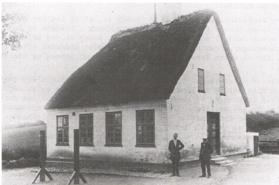
DEN LILLE SKOLE MED "E" TURNENSTATIV"
