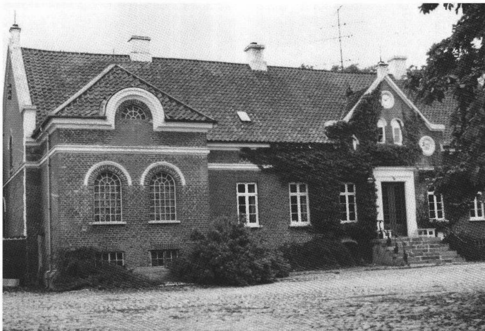
Den herregårdslignende hovedbygning til Cathrineberg er opført i 1867 af Poul Tonnesen (1834-1876). Fællesmejeriet og det senere andelsmejeri på Cathrineberg lå i hovedbygningens østre fløj mod gårdsiden. Ind- og udlosning af mælkejunger skete fra gavlsiden. De gamle mejerivinduer har fået lov til at sidde tilbage, efter at mejeriet i 1894 flyttede ned i byen. Foto 1989.
