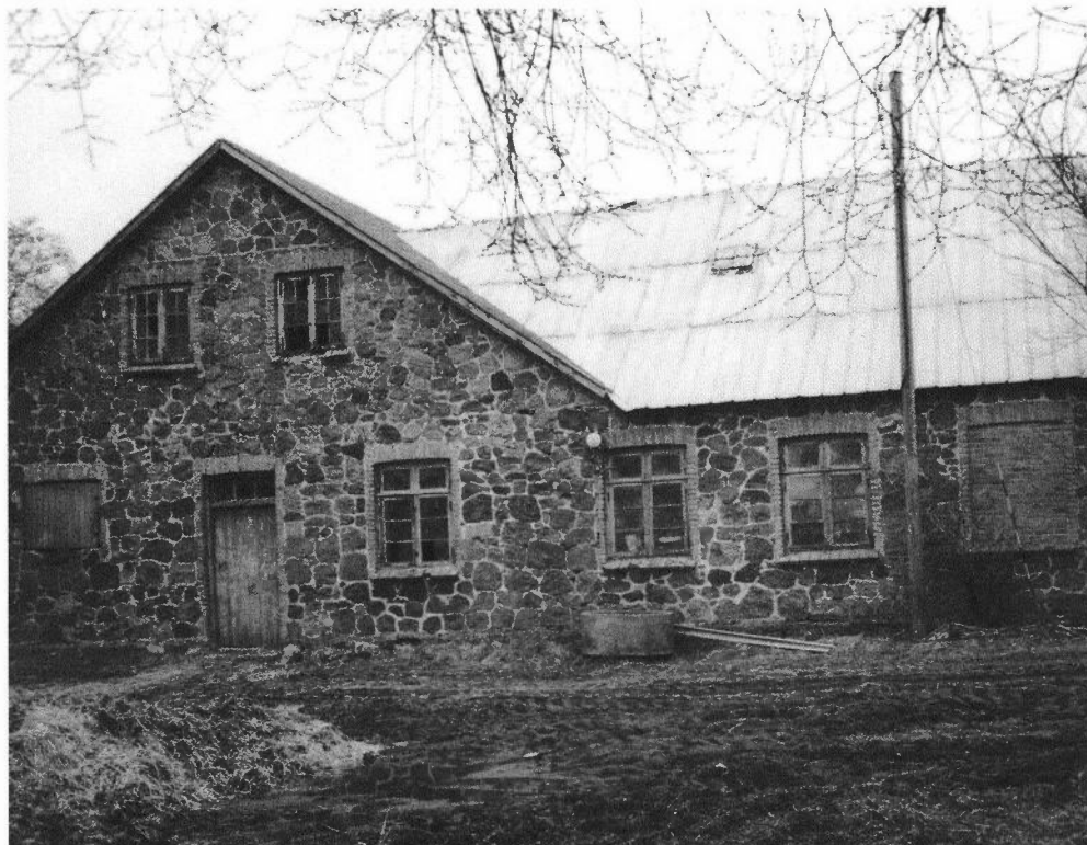
Billede af Kattrup fattiggårds vestgavl med kampestensmur og de vinduer og døre, der nok er de oprindelige. Teglstenene omkring åbningerne er fra et forlængst nedlagt teglværk ved Bledd.
