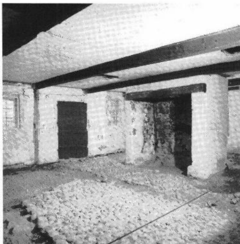
»Badensminde«. Bryggeret, efter at 2 lag cementgulv er fjernet, ser man det oprindelige stenprikke guld og den store bageovn fra 1811.
