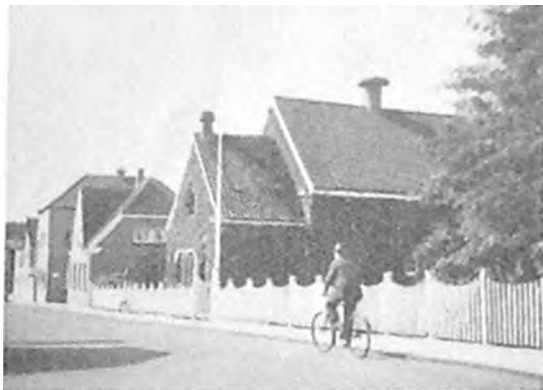
Elektricitetsværket. Til venstre »Dana.«
