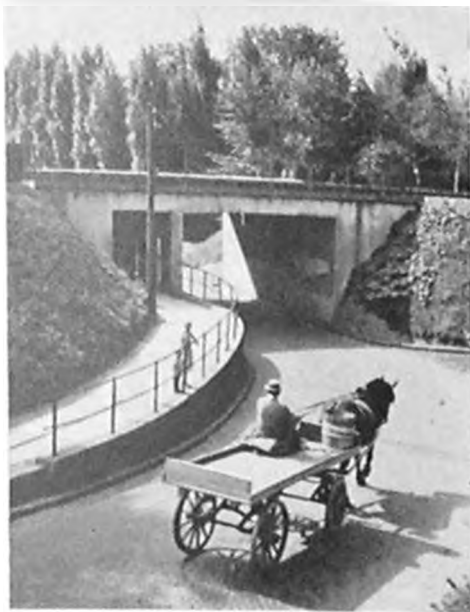
Foto Ragna Zwick. Viadukten. Bygget 1923.
