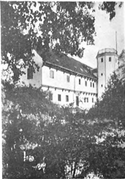
HOVEDBYGNING OG TAARN (set fra Vest)
