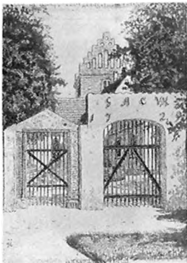
Den gamle Portal paa sin tidligere Plads ved Siden af Portalen i Kirkegaardens Østmur.
