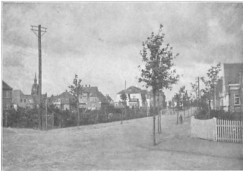
Kvarteret mellem Jernbanelinjen og Godthaabsvej.
