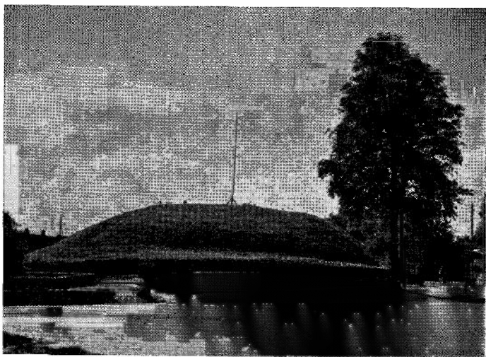
Udsigt til Højen, efter at Bygningen er nedrevet.
