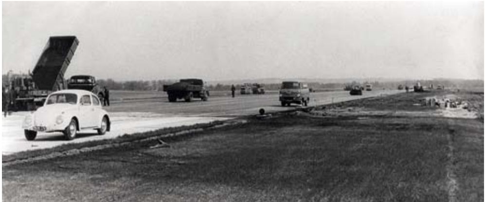
I efteråret 1964 arbejdedes der på bøjtryk for at få alt på plads til åbningen i november. Her er det arbejdet med startbanen. Foto: Billund Lufthavn.
