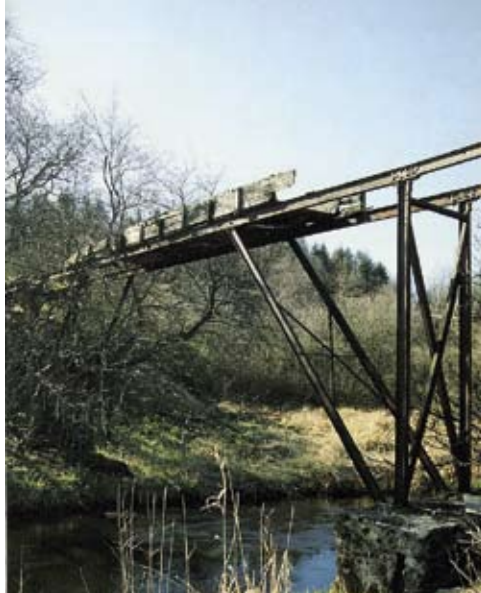
Fra Vejle Amts bog om Kulturbistoriske beskyttelsesområder 1998: Akvadukt ved Hygild Vandingskanal over Holtum Å ved Harrild Hede i den tidligere Nørre Snede Kommune.
