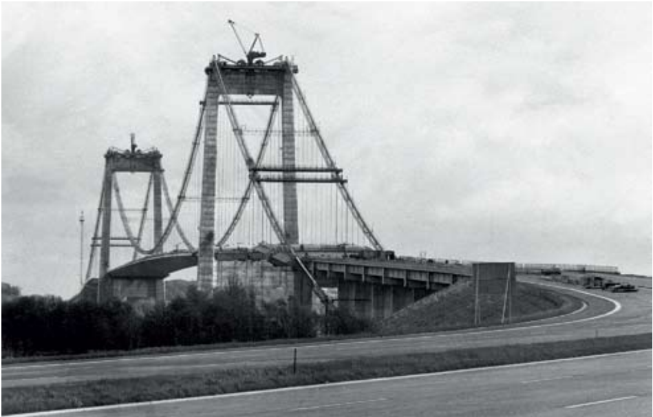
Den næsten færdige motorvejsbro 1970, set fra Jyllandssiden.
