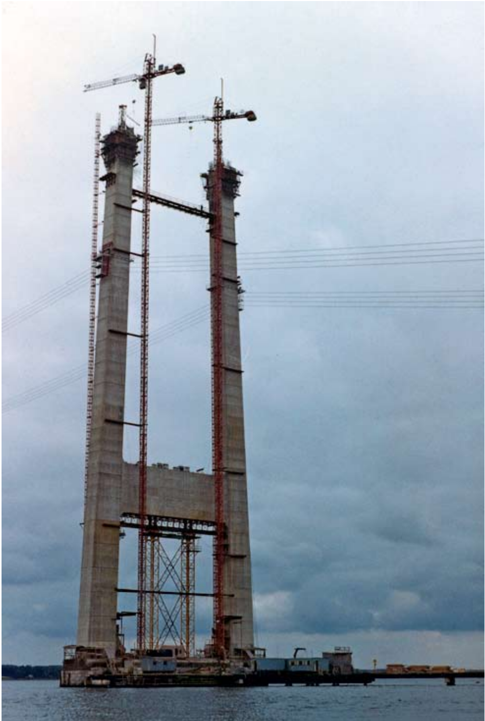
Hovedtårn fotograferet 1968. Begge tårne blev støbt med klatreforskalling og har en samlet højde over vandspejlet på 118 meter. De otte interimistiske bæretøve, man ser, var monteret som stormsikring.
