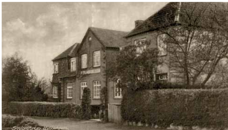
Smidstrup Hvilehjem hvor der er tilbygget fløje både mod nord og syd.
