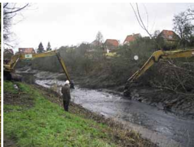
To gravemaskiner arbejder med slammet i voldgraven.
