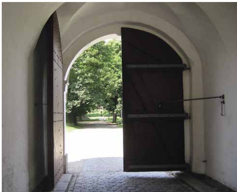
Prinsens Port monteret med nye portfløje.
