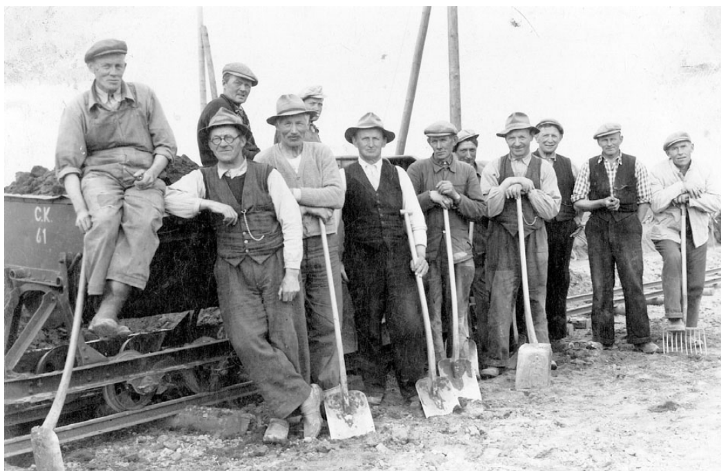
Ved anlæggelsen af Frederikshavn-Østerørå-vejen.
