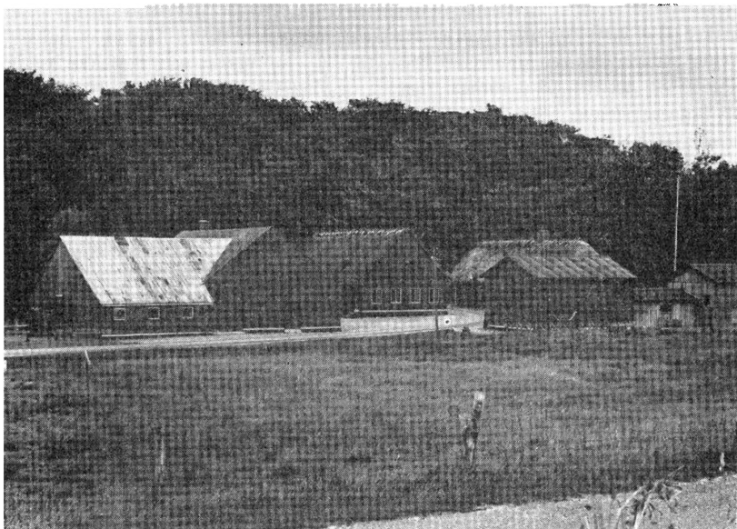
Store Ryde Mølle som den fremtræder i dag, nænsomt moderniseret, nu i rollen som lystgård for ejeren. I midterbygningen med de fire gavlvinduer var der købmandsforretning til ca. midten af århundredet. Bag gården haven med høje træer op ad skråningen.
