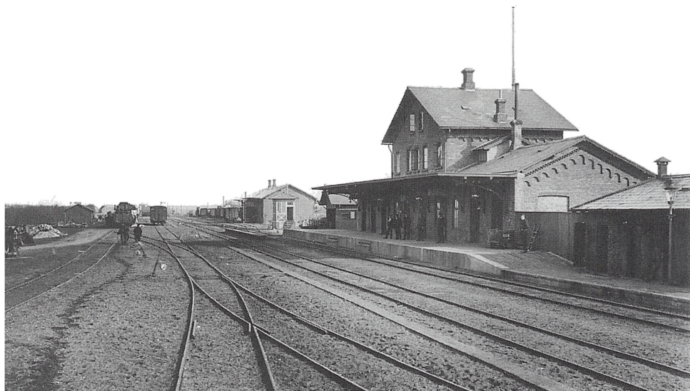
Holstebro station ved århundredskiftet. Billedet indgår i den fotosamling, som DSB's baneafdeling har afleveret til Rigsarkivet. (Foto: Rigsarkivet)
