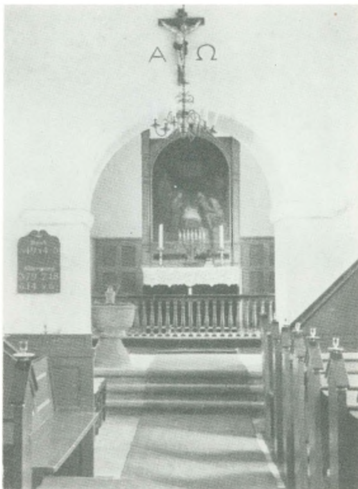
9. Herstedøster kirkes indre set mod altret. Triumfbuen er bevaret. Den gamle døbefønd ses til venstre. Altartavlen er fra 1838, billedet er malt af L. L. Lund og forestiller hyrdernes tilbedelse. Stolestaderne er nye. Tilhøjre, opgang til prædikestolen. Over triumfbuen bronzekrucifiks fra 1000'erne.
