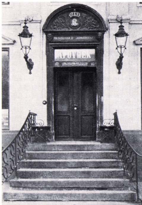
Indgangen med trappe og sandstensportal.
