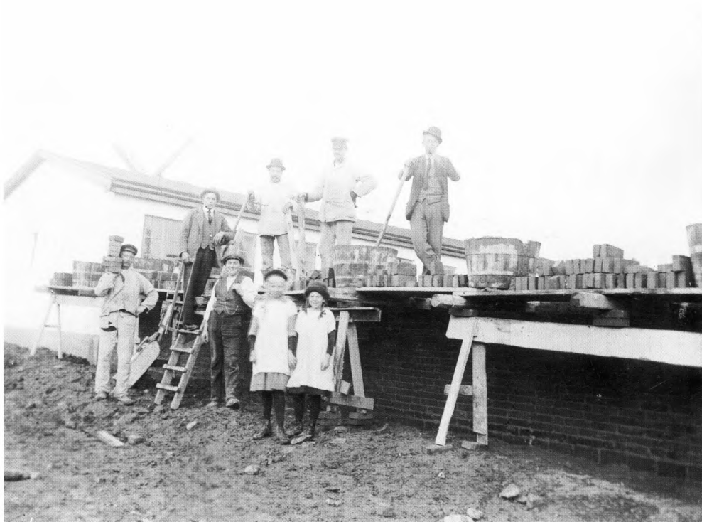
Arbejdere på stilladset under opførelse af barakkerne.
