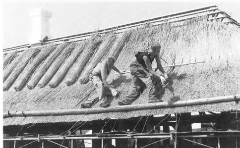
I sommeren 2002 fik Martha Henriksens hus lagt stråtag af rumænske rør. Arbejdet blev udført af Benny Jørgensen, Jerlev.
