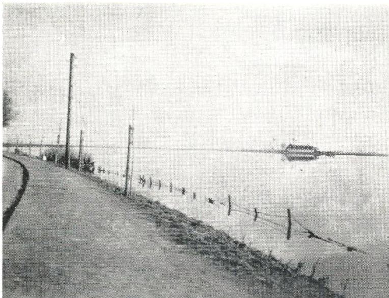
VINTERBILLEDE AF INDVANDET SYD FOR TØNDER FØR AFVANDINGEN.
