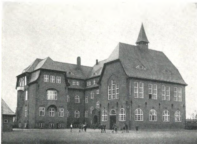
TØNDER STATSSKOLE, OPFØRT 1909-10.
