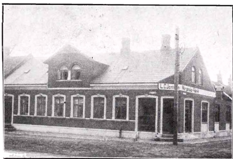
L. C. Jensens Sko- & Sadelbetrækfabrik.
