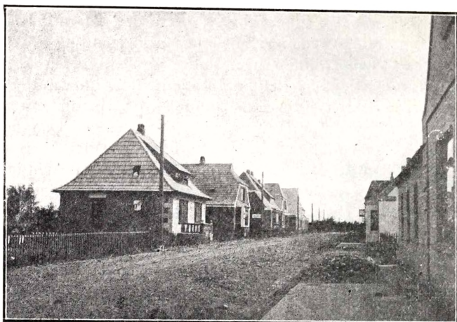
Dalgasvej i Brande. (opført af Murerm. K. A. Larsen)
