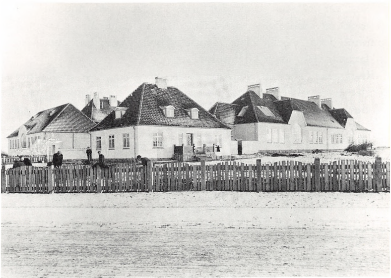
Engelsborgskolen 1909, set fra nordvest (fra Bagsværdvej). Til venstre gymnastiksalen, i midten inspektørboligen og til højre den vestlige pavillon, der var den første, der blev indrettet til hospital.
